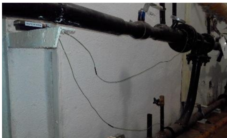
Рисунок 3 – Элеваторный узел системы отопления
